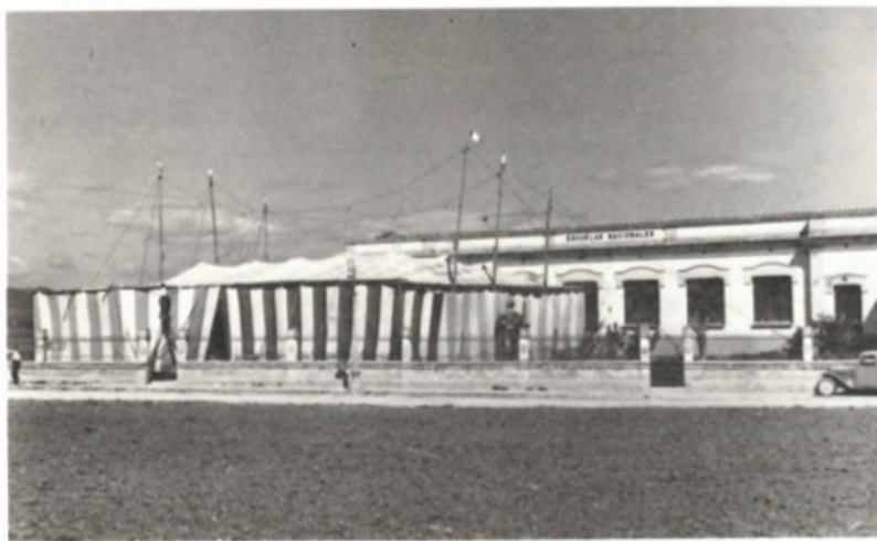
Les escoles nacionals construïdes l'any 1924, en una curiosa fotografia del 1955, amb l'envelat de la festa major plantat al pati.
